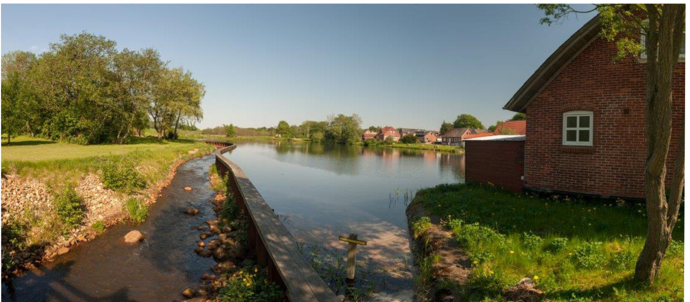
Ganer Å omløbet er lagt uden om Møllesøen, adskilt fra den med en spunsvæg. (Foto: Per Søby Jensen)
